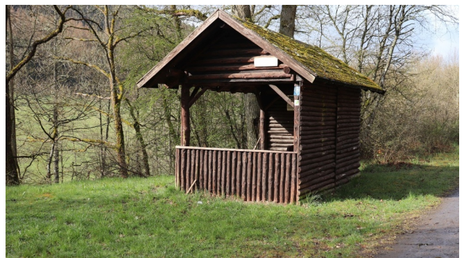
Schutzhütte an der Abzweigung des Weges
