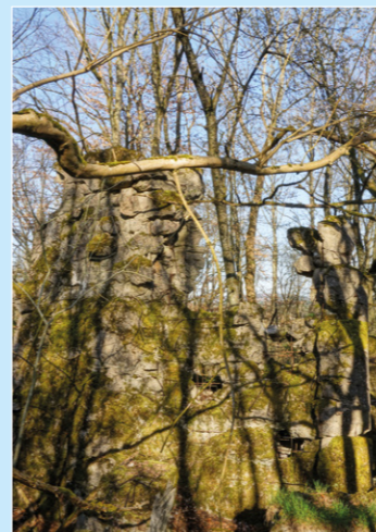
◀ Opgeblazen Westwall-bunker van gewapend beton met mossen en korstmossen.
