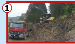
1 Aanleg van landbouwwegen
