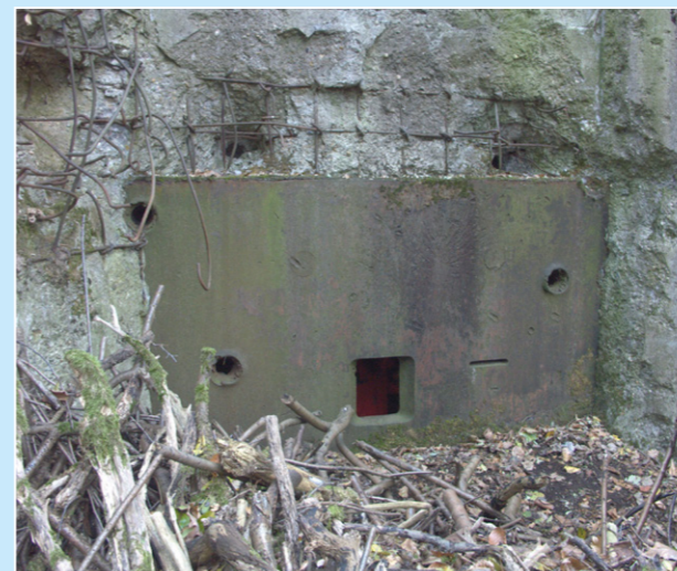
▲ Bedrieglijke bescherming! Deze pantserplaat werd gewoon doorboord door drie 76mm-granaten.
