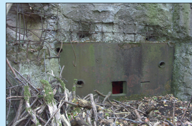
▲ Drie schoten van een 76mm kanon drongen soepel door de pantserplaat van zacht gewalst staal.
