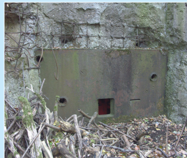
▲ Trügerischer Schutz! Diese Schartenplatte wurde von drei 76mm-Granaten glatt durchschlagen.
