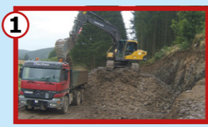
1 Bau von Wirtschaftswegen
