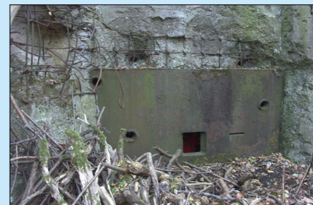
▲ Drei Schüsse aus einer 76mm-Kanone haben die Schartenplatte aus weichem Walzstahl glatt durchschlagen.
