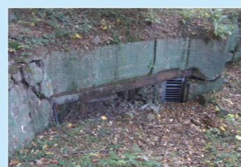
◀ Angesprengter Bunker im Hürtgenwald mit Stahlgittertüren für Fledermäuse.
