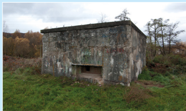
▲ Regelbau 1 mit Schartenplatte bei Koerprich im Saarland.
